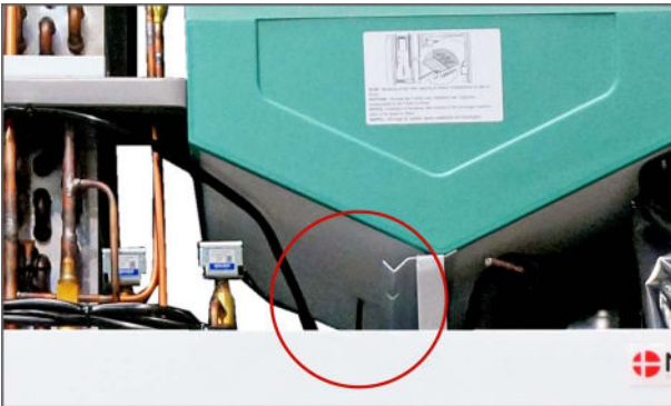
1. Poista T4 lämpötila-anturi lämmönvaihtimesta.
