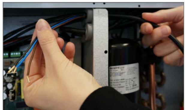
6. vedä johto anturilta kaapeliläpiviennin kautta automatiikalle. Johto kiinnitetään paikoitellen johtokiinnikkeillä.
